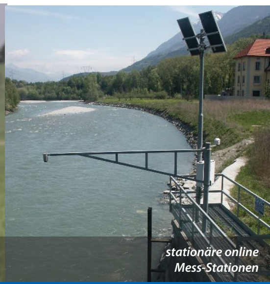
FlashCom/LogCom Onlinemessung im Grundwasser
